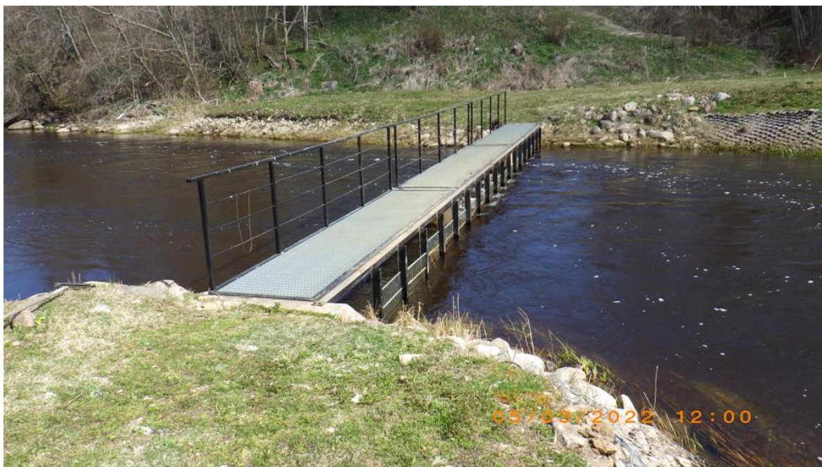
Foto 2. Sillaoru hüdroelektrijaama alaveepoolne kalatõke derivatsioonikanali suubumisel jõkke (vaade tammi otsast, kanali vasakult kaldalt)
