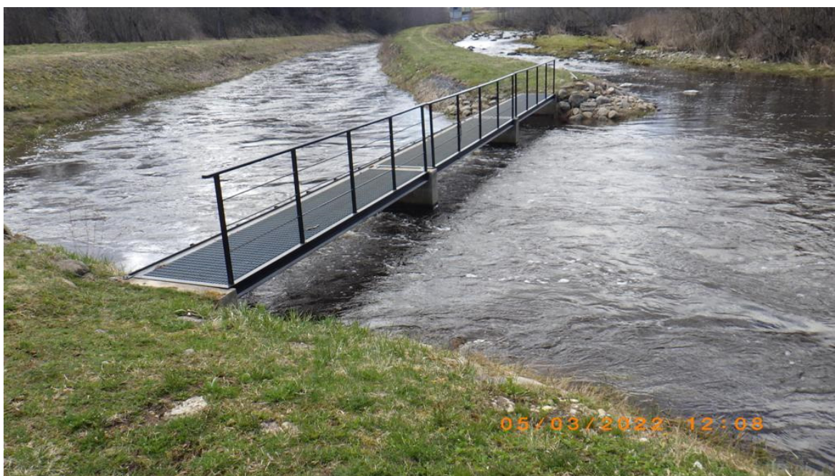
Foto 1. Sillaoru hüdroelektrijaama alaveepoolne kalatõke derivatsioonikanali suubumisel jõkke (vaade paremalt kaldalt ülesvoolu)
